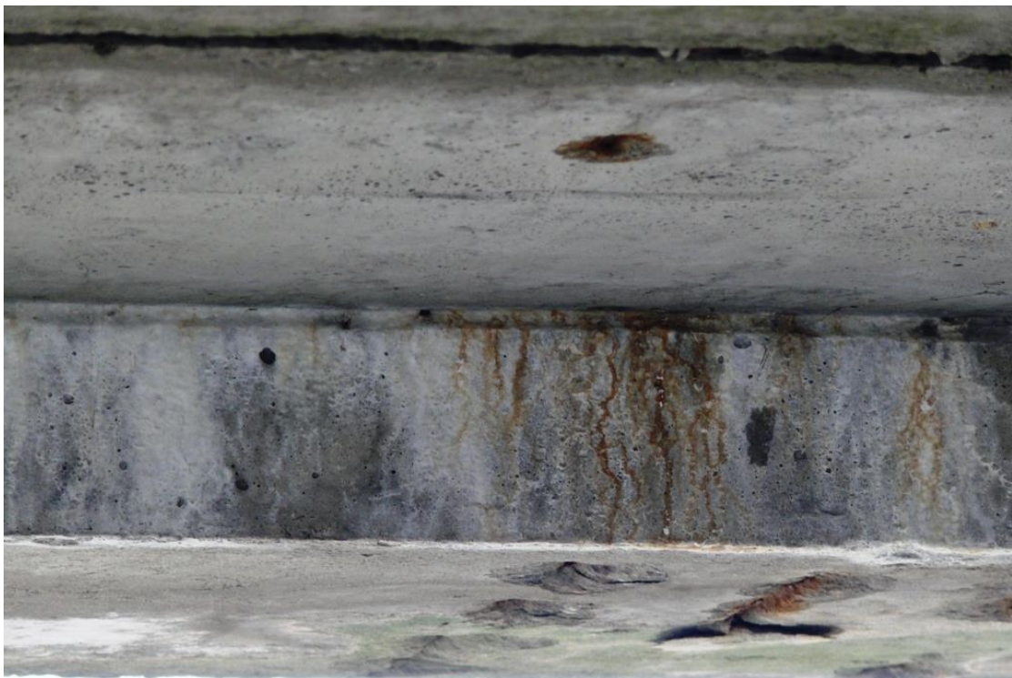
Fot.Nr.15. Dźwigar skrajny od strony WD. Uszkodzenia jak w dźwigarze od strony WG (fot.nr.14). Stalaktyty na betonie.
