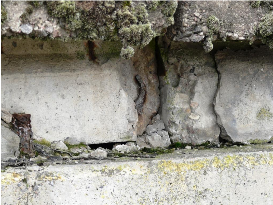
Fot.Nr.30. Korozja i ubytki betonu w strefie dylatacji na podporze środkowej .
