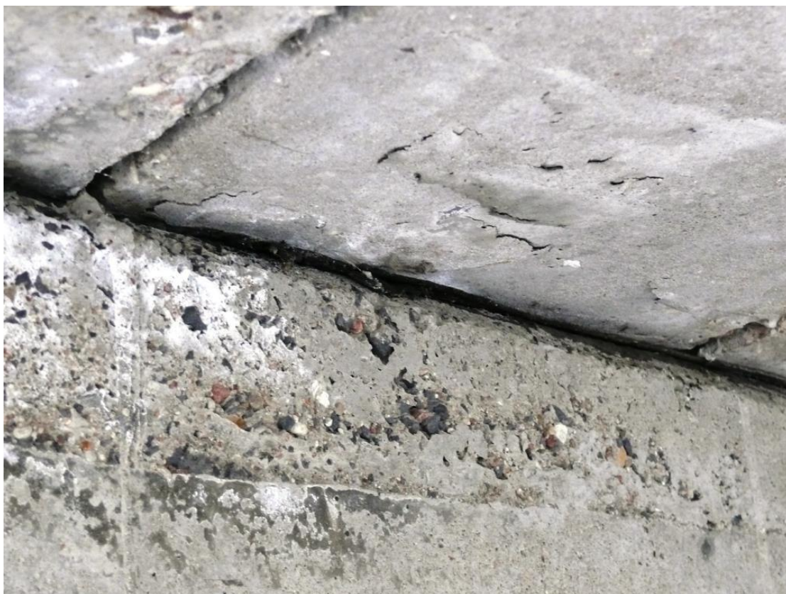
Fot.Nr.25 Belki na podporze skrajnej lewobrzeżnej. Korozja betonu , ubytki betonu.
