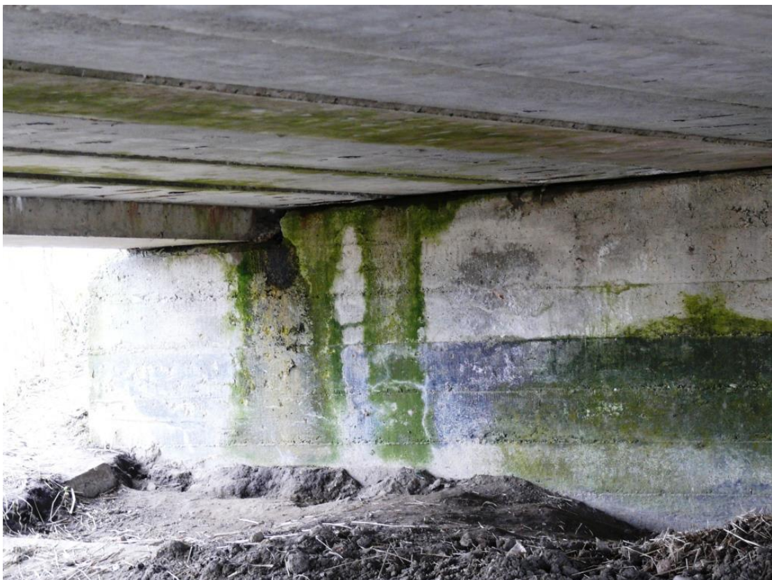
Fot.Nr.32. Widok podpory skrajnej .Przyciótek prawobrzeżny. Nacieki świadczące o nieszczelnej izolacji W strefie dylatacji.
