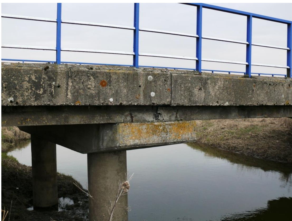
Fot.Nr.10. Zanieczyszczenia gzymsu. Wegetacja roślin na oczepte. Korozja betonu gzymsu. Podpora lewobrzeżna widok od strony WD.
