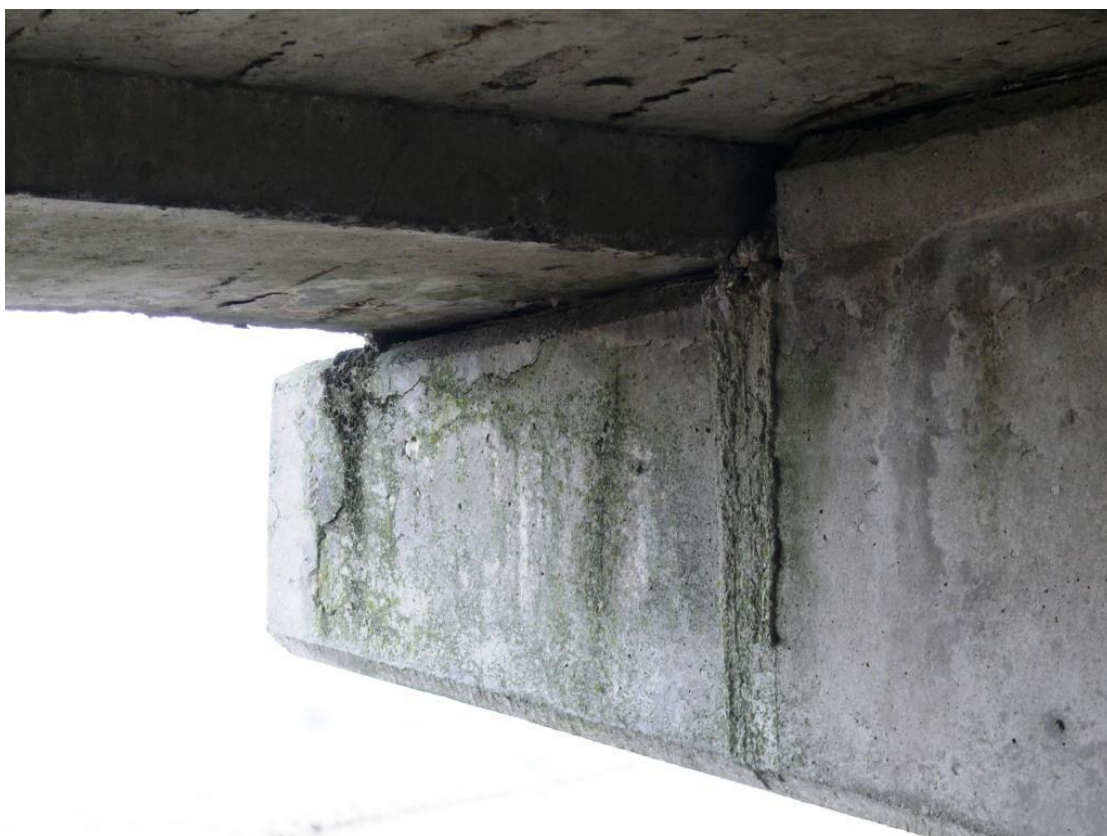
Fot.Nr.24. Oczep podpory środkowej lewobrzeżnej. Wykwity i nacieki.
