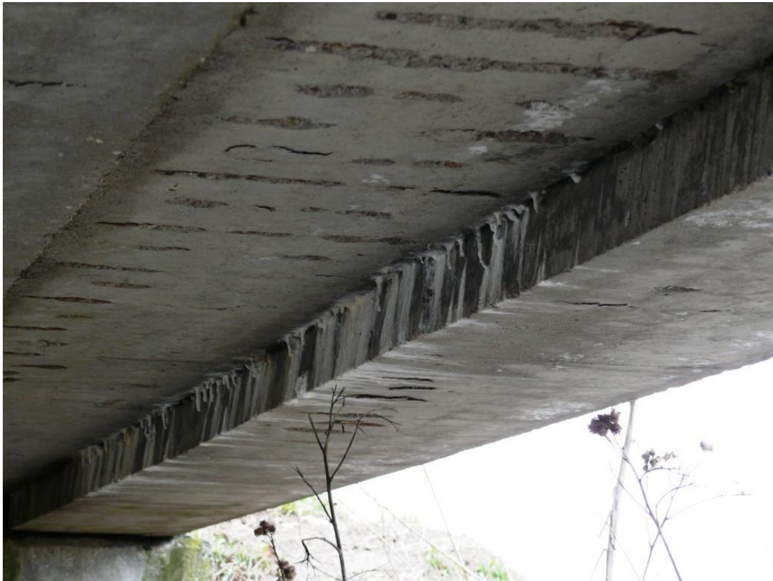
Fot.Nr.15. Dźwigar skrajny od strony WD. Uszkodzenia jak w dźwigarze od strony WG (fot.nr.14). Stalaktyty na betonie.
