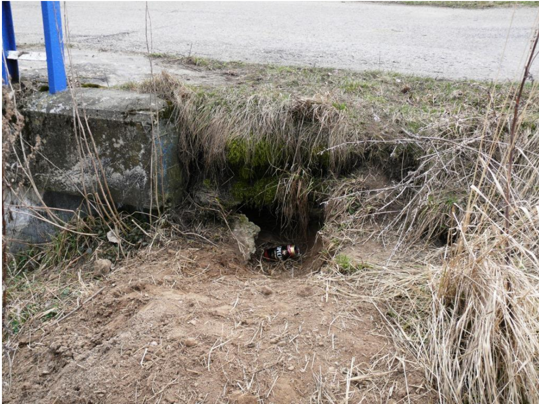
Fot.Nr.34. Ubytki gruntu w skarpie za skrzydełkiem prawobrzeżnym od strony WG z kierunku Lwowca. Możliwą przyczyną może być ingerencja bobrów.
