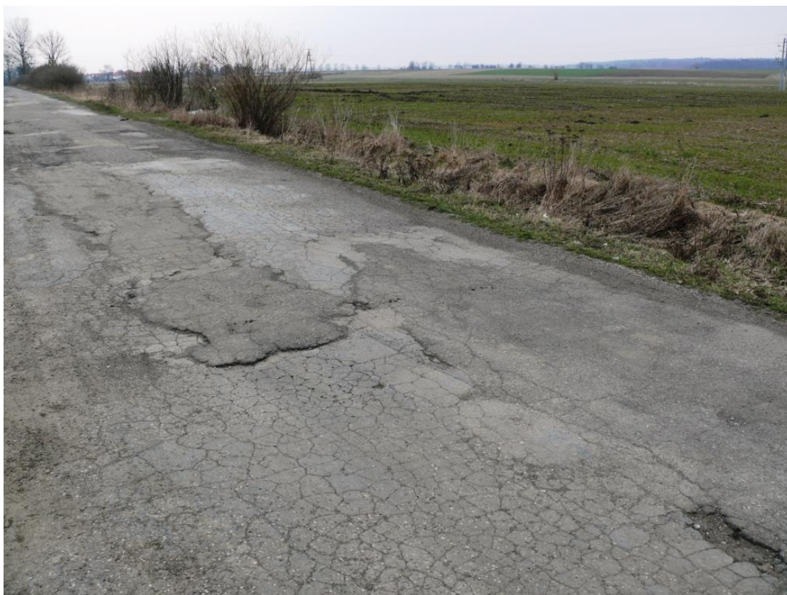
Fot.Nr.6. Nawierzchnia jezdni na dojeździe do mostu od strony m. Lwowiec. Pęknięcia siatkowe. Ubytki.
