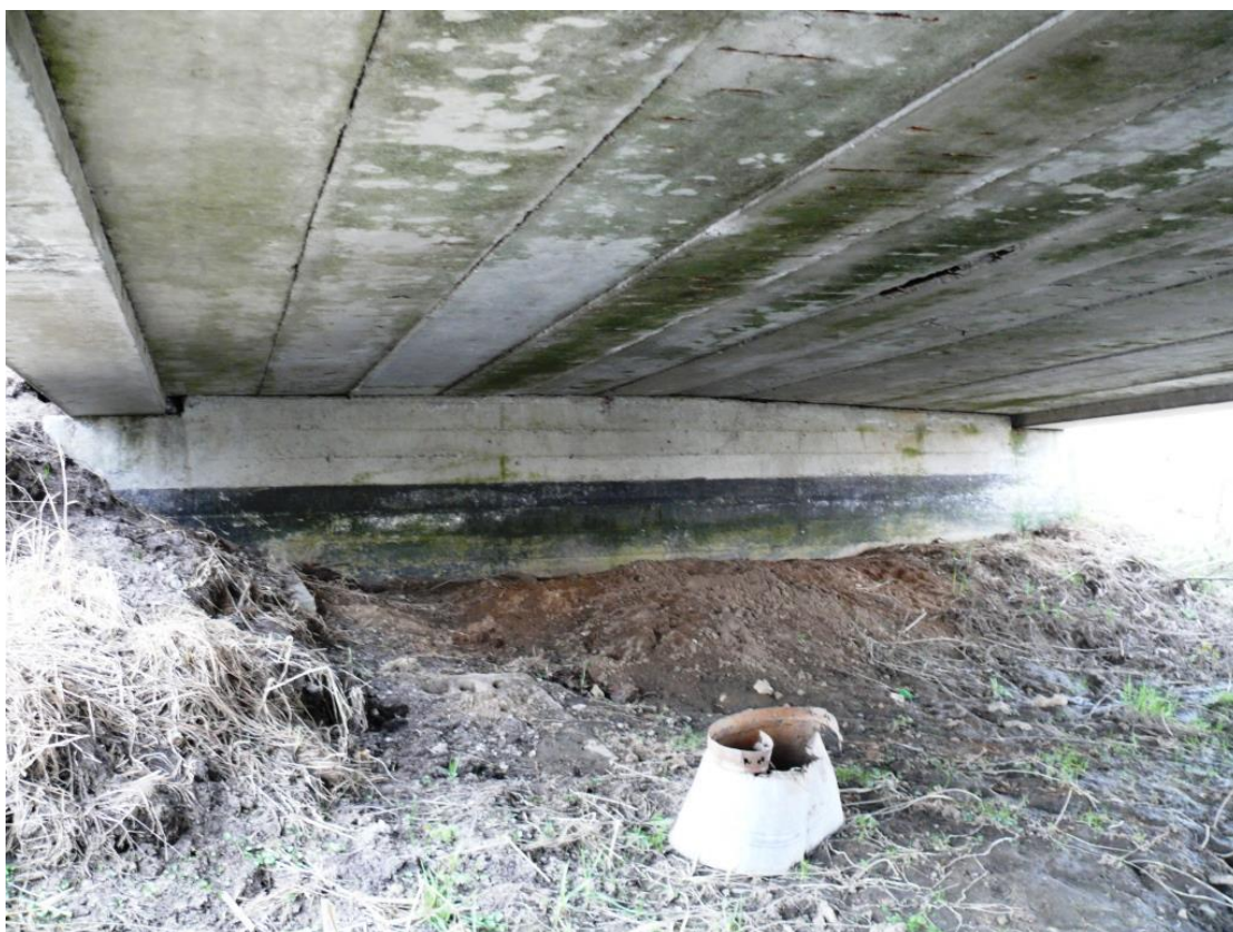
Fot.Nr.12. Widok pomostu od spodu. Przyczółek lewobrzeżny. Ubytki gruntu przy podporze. Brak umocnienia skarpy. Miejscowo odkryte i skorodowane zbrojenie belek typu „Gromnik”. Zanieczyszczenia, wykwyty i nacieki na ścianie przyczółka. Przecieki pomiędzy belkami pomostu.
