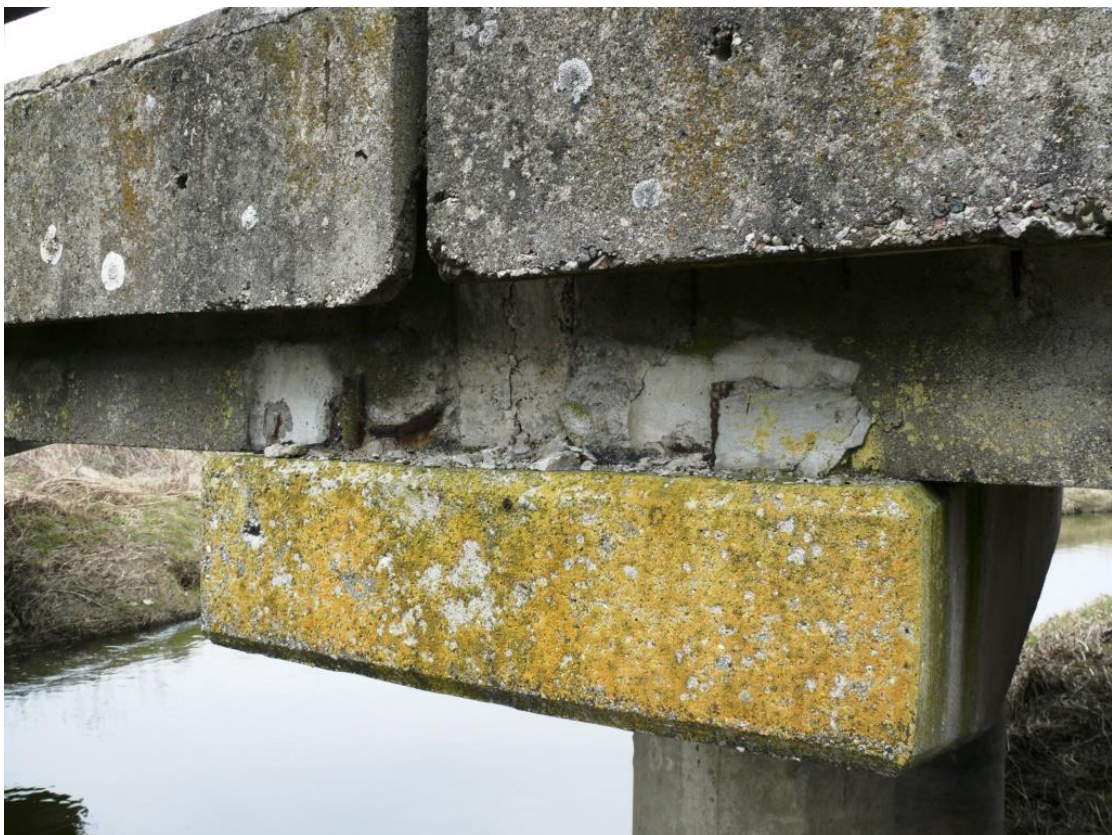
Fot.Nr.18. Szczelina dylatacyjna i oczep prawobrzeżny. Widok od strony WG. Zanieczyszczenie betonu. Wegetacja porostów. Korozja betonu i ubytki betonu.
