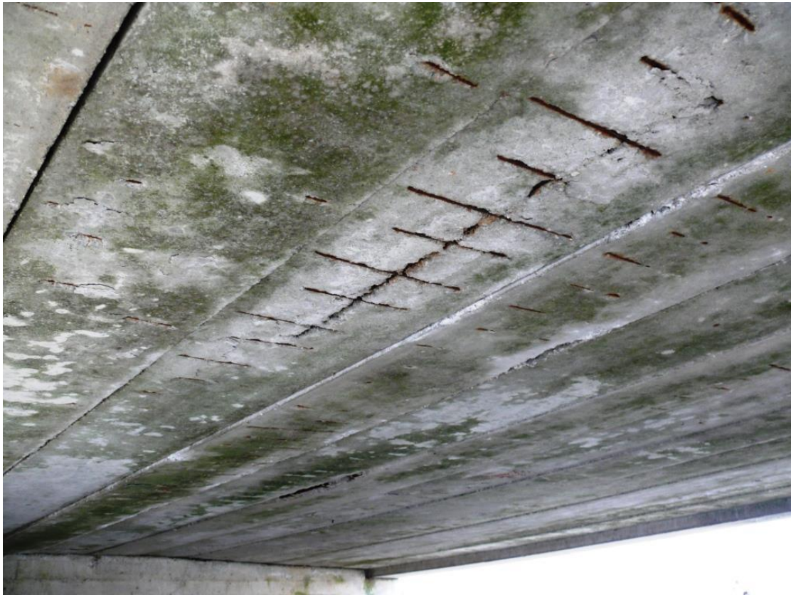
Fot.Nr.13. Widok pomostu od spodu. Miejscowo odkryte i skorodowane zbrojenie belek typu „Gromnik”. Błąd w prefabrykacji belek. Wykwity i wyługowania świadczą o uszkodzonej izolacji.
