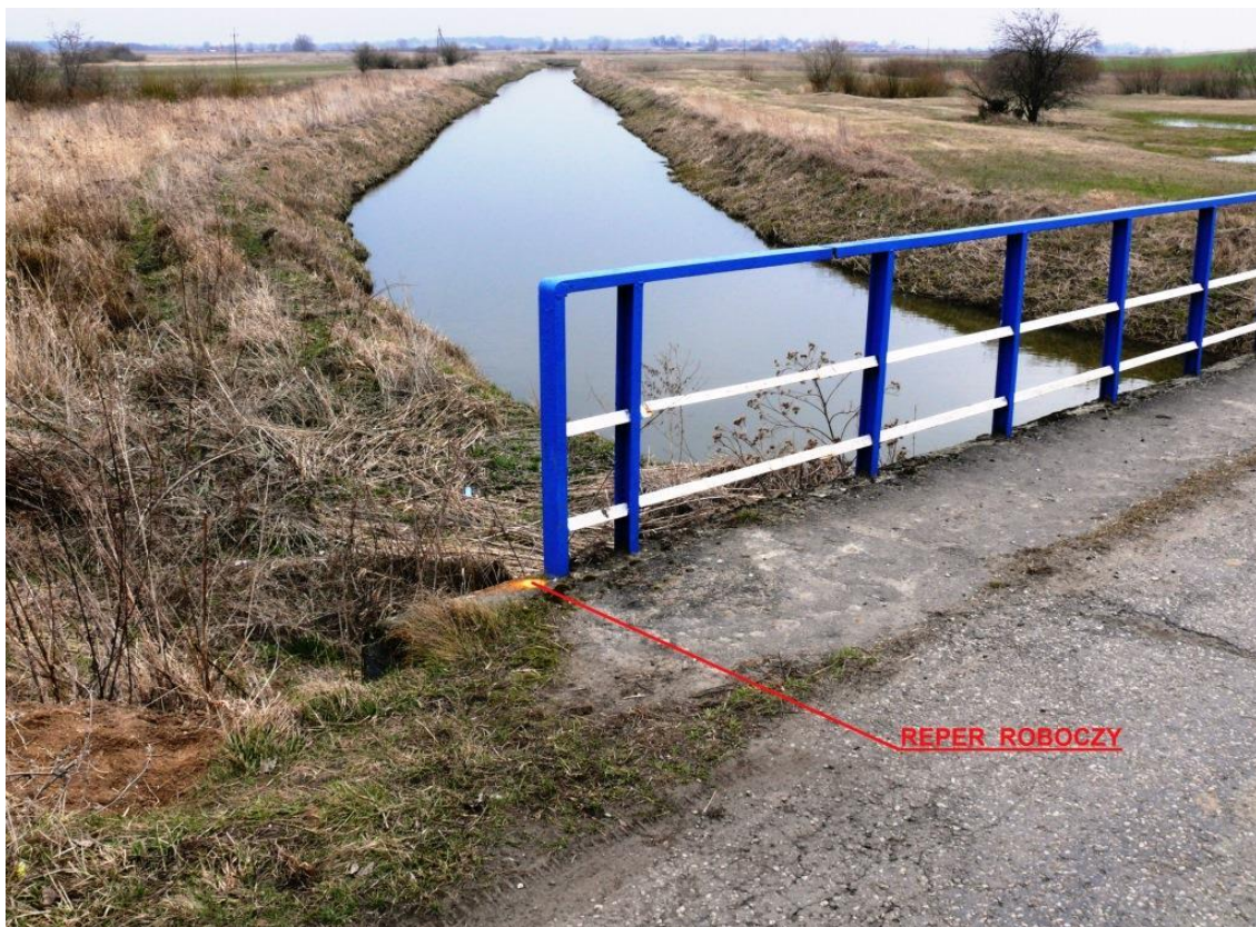
Fot.NR.39. Lokalizacja Rr o założonej wysokości (w układzie lokalnym) H = 100,00 . Reper roboczy zlokalizowany jest na górze skrzydełka prawobrzeżnego od strony WG na dojeździe do mostu od strony Lwowca.
