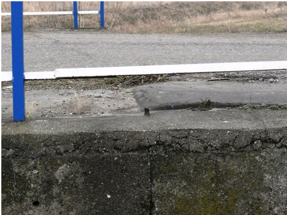
Fot.Nr.37. Korozja betonu na gzymsach. Deformacja nawierzchni w strefie chodnika.
