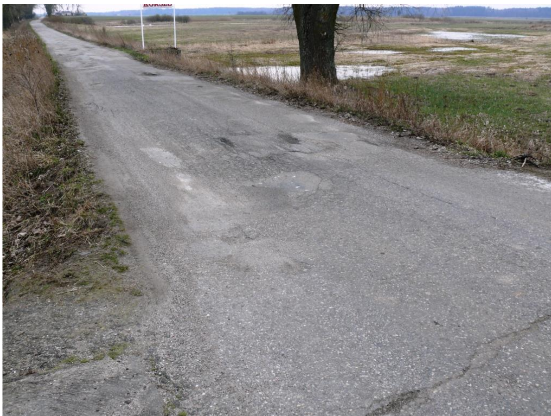
Fot.Nr.7. Nawierzchnia jezdni na zjeździe z mostu w kierunku m. Marłuty. Pęknięcia poprzeczne Ubytki
