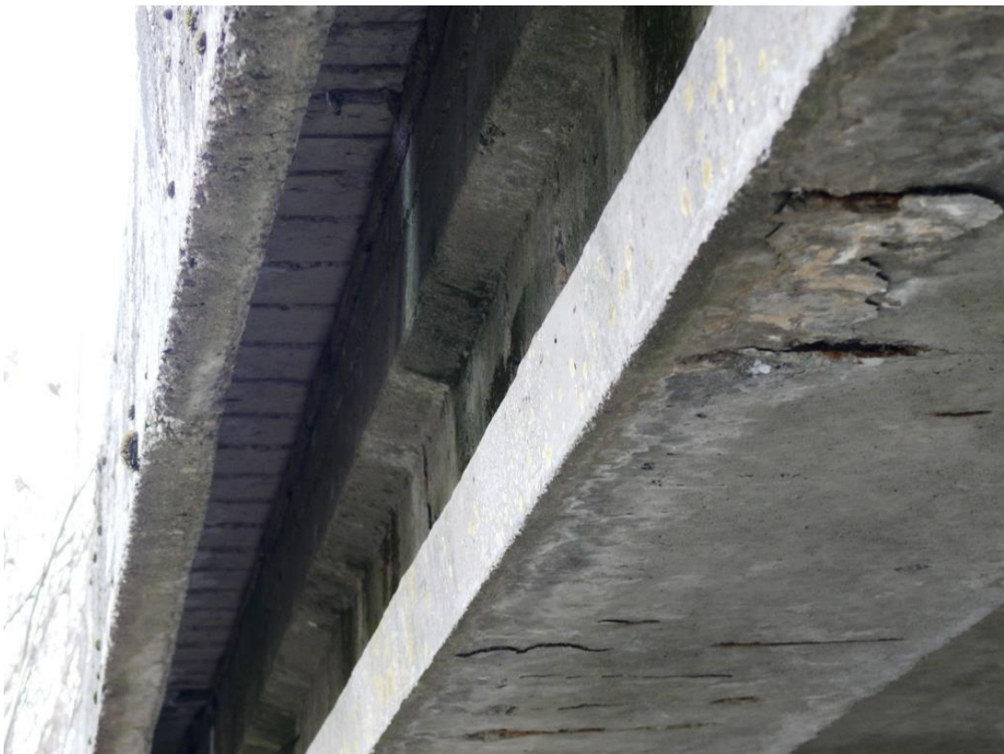
Fot.Nr.14. Spód i bok dźwigara skrajnego od strony WG. Odpryski betonu (korozja betonu). Wykwity i wyługowania.
