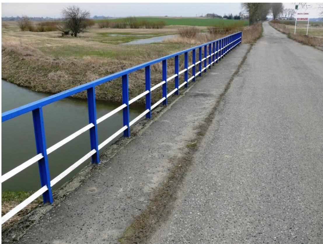
Fot.Nr.8. Widok poręczy ochronnej i opaski chodnikowej od strony WG. Zanieczyszczenia jezdni przy „quasi” krawężniku.
