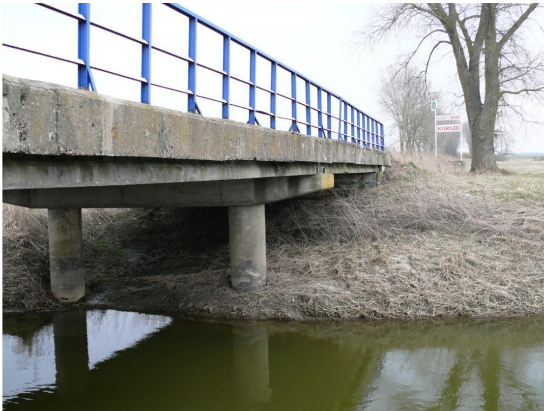
Fot.Nr.11. Podpora lewobrzeżna. Zanieczyszczenia gzymsu. Wegetacja roślin na oczeple. Zacieki wody na oczeple. Miejscowa korozja betonu gzymsu. Widok od strony WD.
