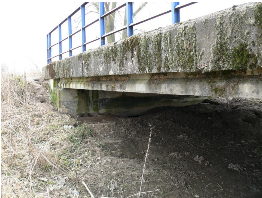
Fot.Nr.28. Widok gzymsów od strony WG. Wegetacja roślin. Nacieki na ścianie przyczółka świadczą o nieszczelnej izolacji w strefie dylatacji.
