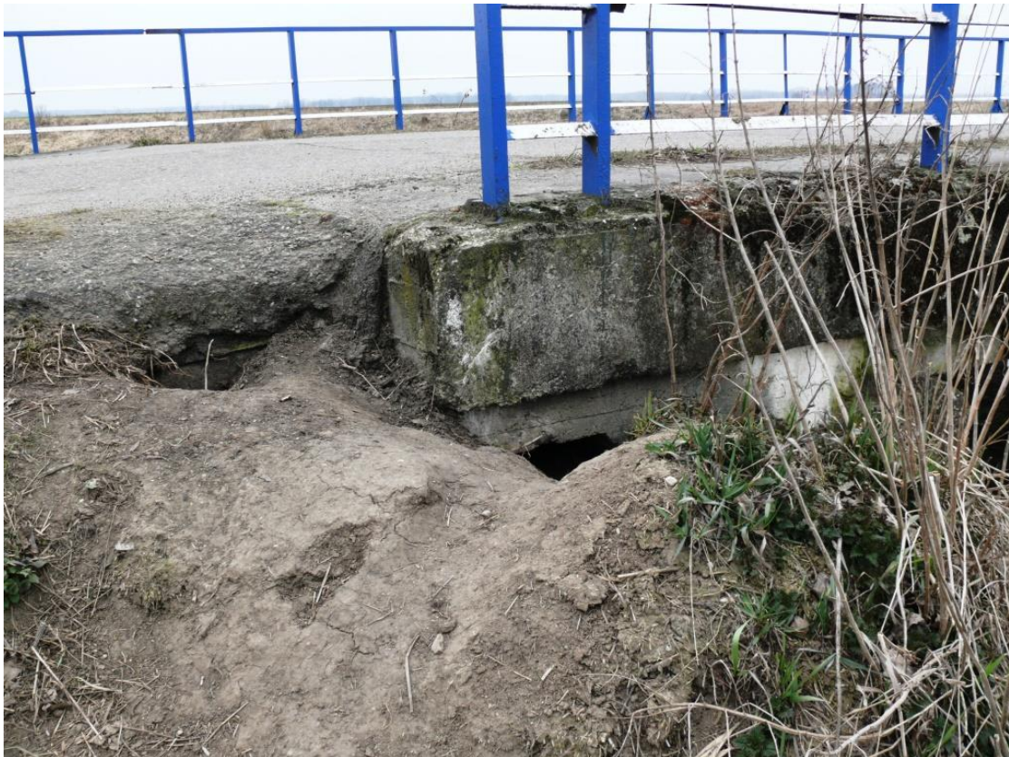
Fot.Nr.36. Ubytki gruntu w skarpie za skrzydełkiem prawobrzeżnym od strony WD z kierunku Lwowca. Możliwą przyczyną może być ingerencja bobrów.
