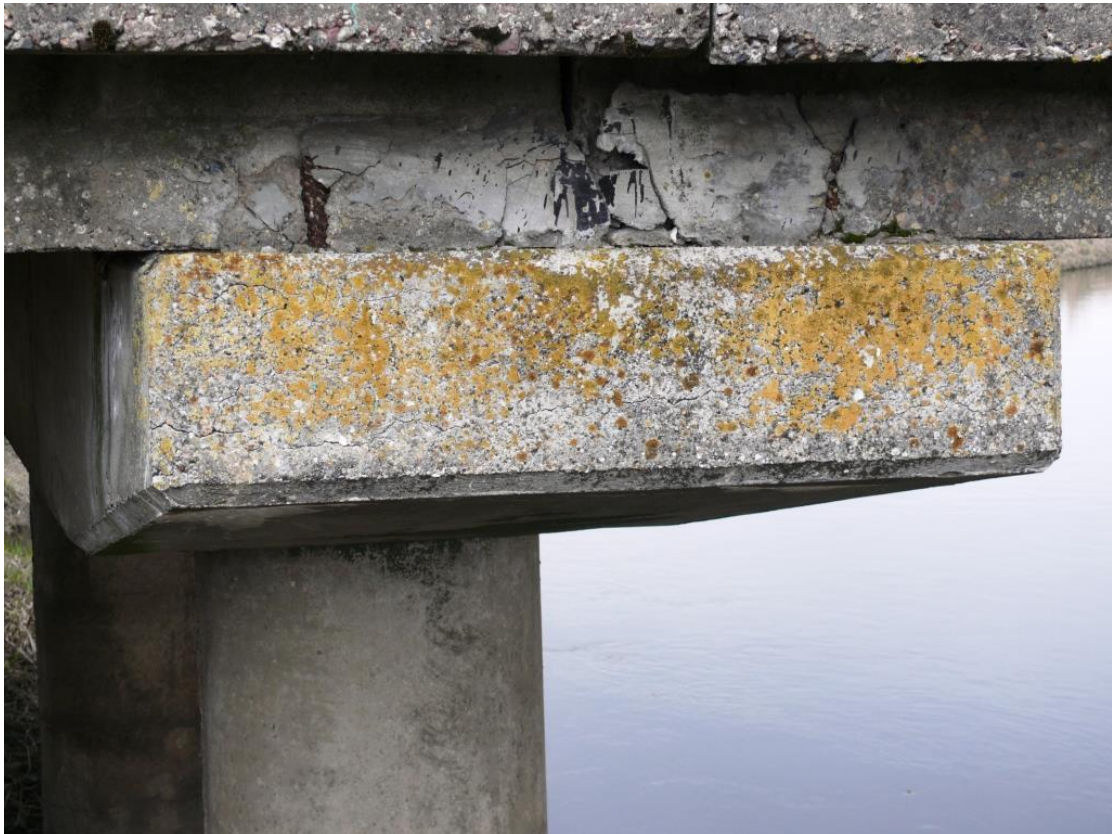
Fot.Nr.17. Oczep podpory prawobrzeżnej. Wegetacja porostów. Korozja betonu gzymsów ubytki betonu.
